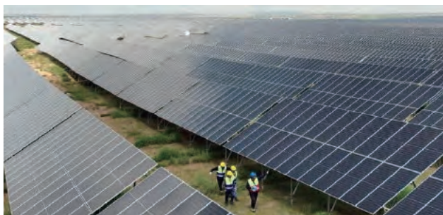
宁夏盐池大型光伏复合项目
