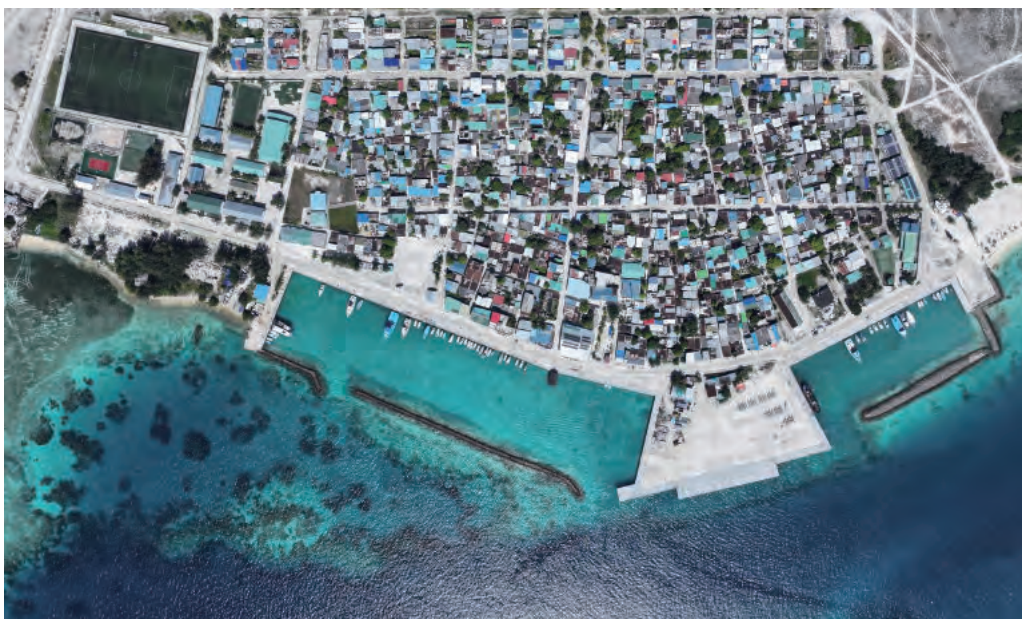
科林电气马尔代夫群岛零碳供电工程俯瞰
